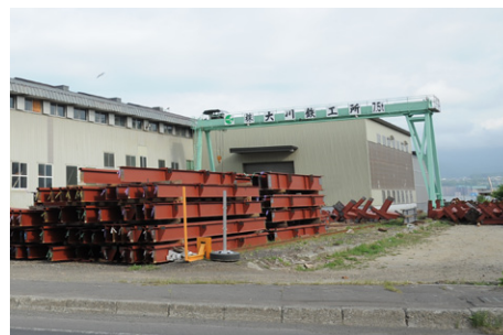
10T の橋形クレーン
