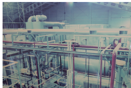
改修前の高島工場内
